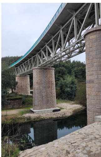
Figura 11. Ponte ferroviária. Foto: Beatriz Rocha, 2024.
