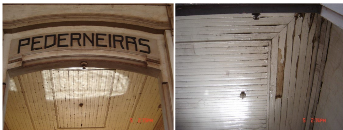
Figura 10. Fotos anteriores a 2007 do forro da estação. Fonte: Secretaria Municipal de Cultura e Turismo de Pederneiras.
