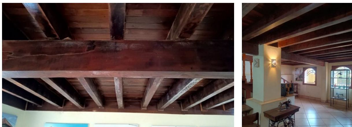
Figura 6. Fotos internas da estrutura do piso do térreo. Fonte: Da autora, 2014.
