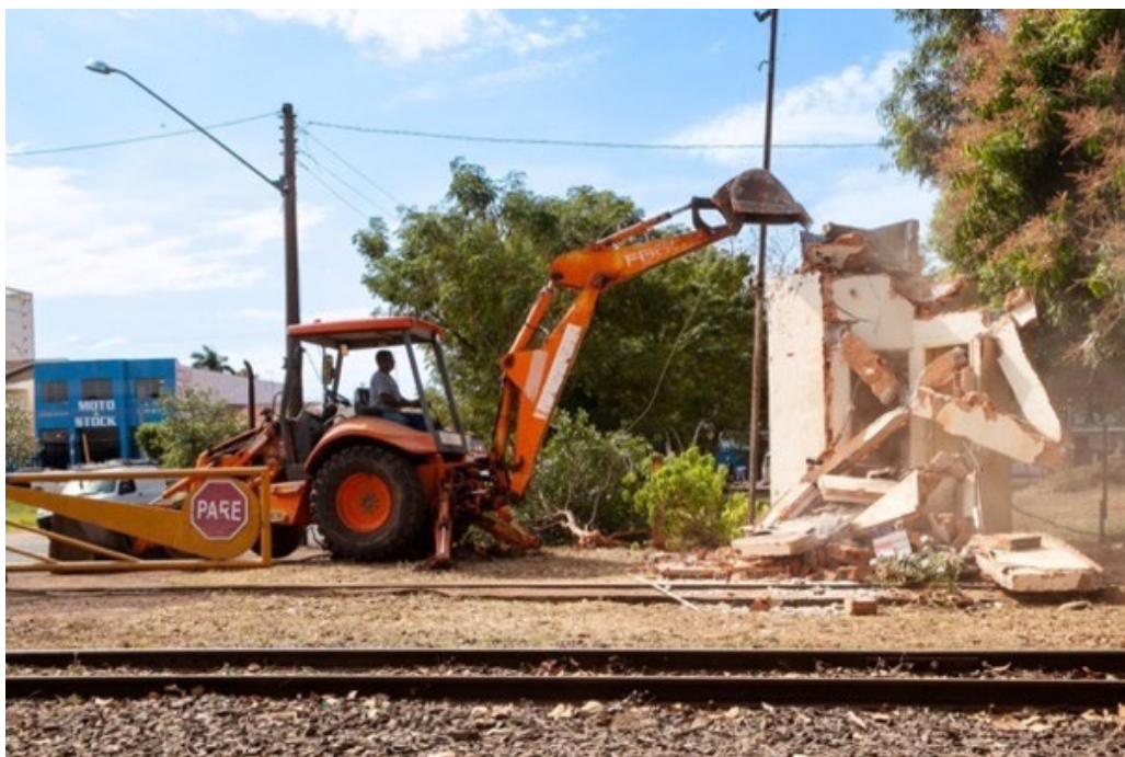
Figura 10. Demolição da cabine de sinalização em Andradina. Fonte: Web Site da Prefeitura Municipal de Andradina (2022) .
