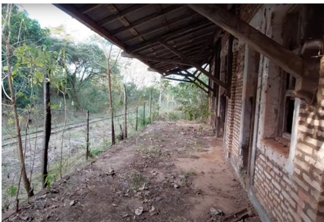
Figura 17. Estação Ferroviária de Agachi. Fonte: Youtube Canal Sucatas e Entretenimentos (2023).
