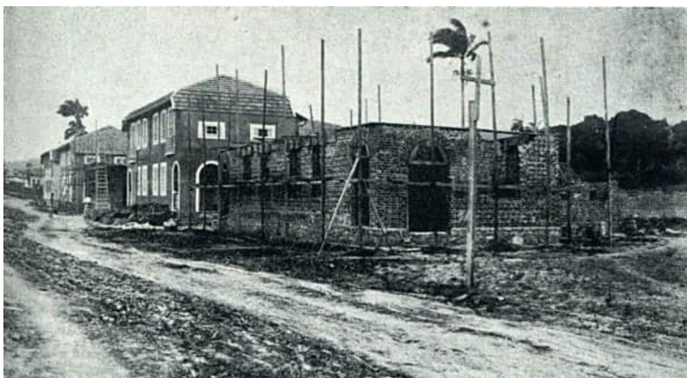
Figura 2. Visão lateral do conjunto de casas sendo construídas Vila Operária Neves.
