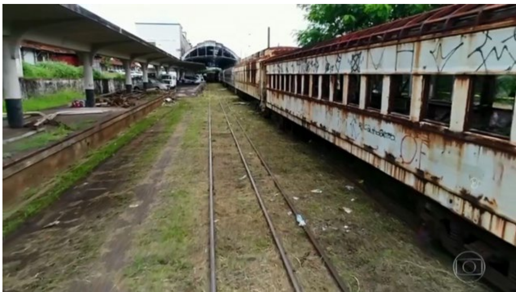
Figura 14. Trilhos e vagões da estação de Bauru. Fonte: Web Site G1 (2018).
