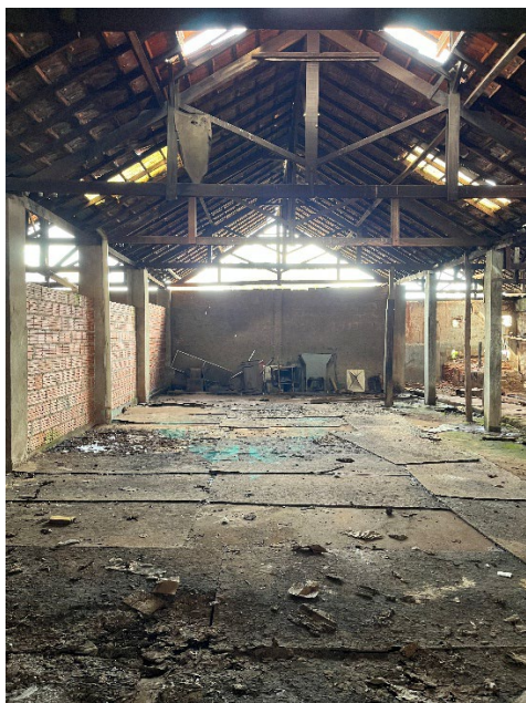
Figura 6. Vista interna do curtume São Sebastião. Fonte: autora (2021).
