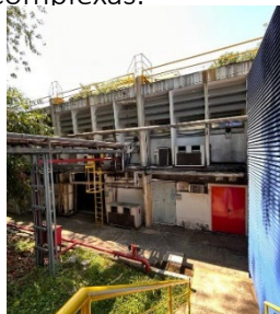
Figura 5: Pavilhão Henrique Aragão
