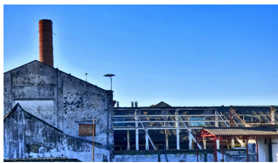
Figura 7. Remanescente do Frigorífico Armour, Santana do Livramento.
