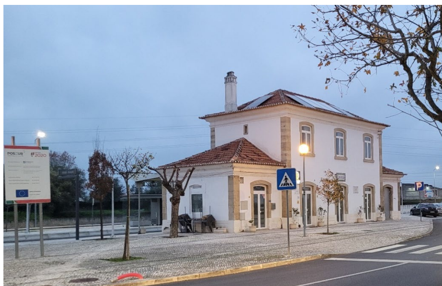
Figura 2. Estação de Lousã. Foto: Beatriz Rocha, 2024.
