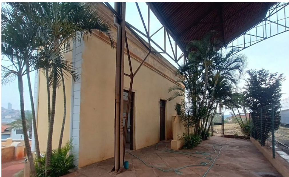
Figura 3. Foto do anexo construído entre 2007/2008. Fonte: Da autora, 2024.
