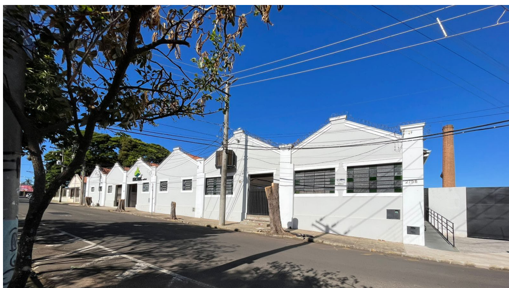
Figura 15. Fachada curtume Spessoto. Fonte: autora (2021).
