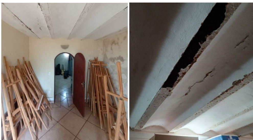
Figura 4. Fotos da área do subsolo. Fonte: Da autora, 2014.
