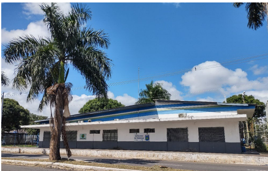
Figura 4. Aspecto atual da estação de Campinas, cumprindo a função de sede do Batalhão de Terminal da Polícia Militar do Estado de Goiás. Nota-se a cobertura com a geometria modificada, eliminando-se o lanternim e encobrindo as esquadrias altas.
