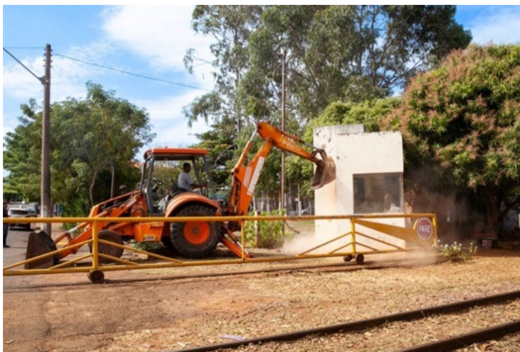
Figura 9. Demolição de vestígios ferroviários em Andradina. Fonte: Web Site da Prefeitura Municipal de Andradina (2022).
