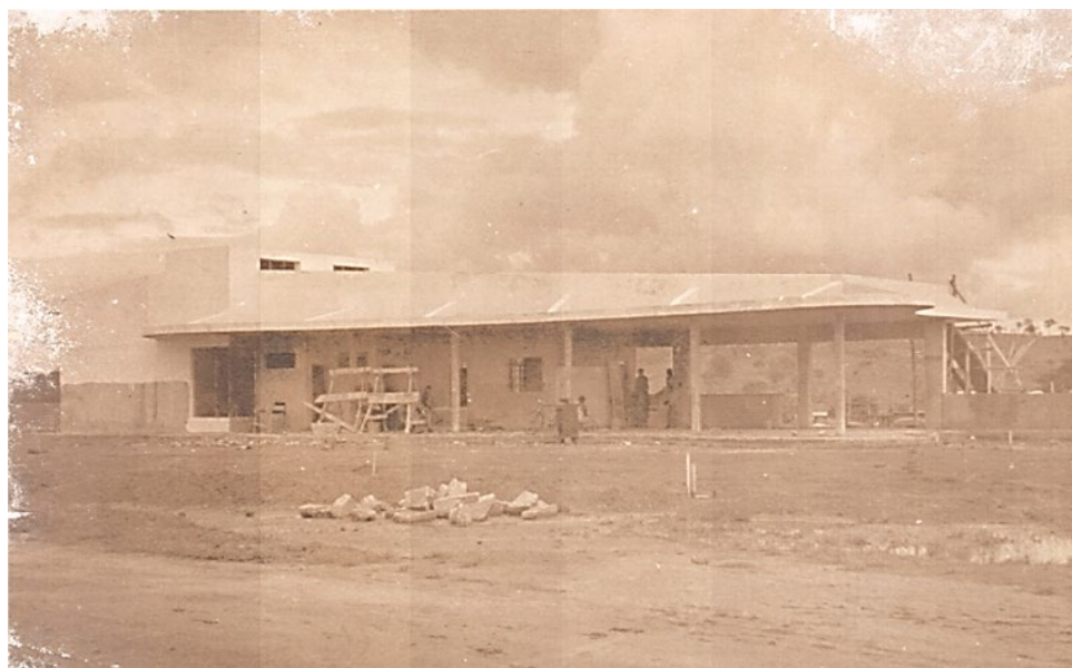
Figura 2. Estação ferroviária de Campinas em construção, por volta de 1957.
