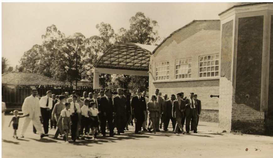
Figura 17. Imagem da visita do Governador Garcez, 1954. Destaque para os novos barracões com cobertura metálica.
