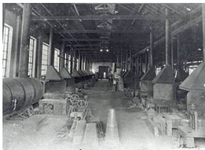
Figura 13. Ferraria da Companhia Mogiana, não com sheds, mas sim com lanternim central
