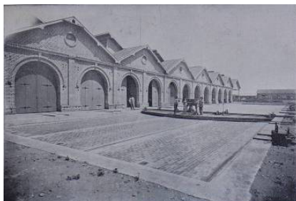
Figura 15. Vista geral da seção nas oficinas novas da Companhia Mogiana
