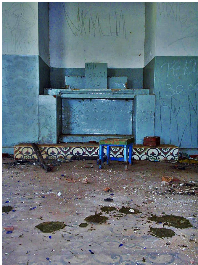
Figura 8. Interior da Capela de Nossa Senhora Aparecida em 2005. Destaque para o ladrilho hidráulico ainda existente.
