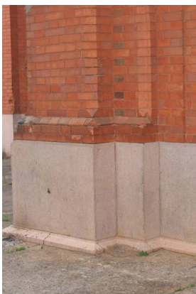
Figura 5. Plinto de cantaria sob a base de uma das pilastras
