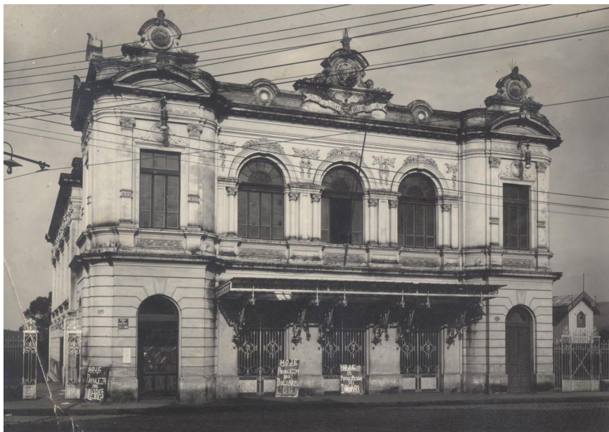
Figura 12: Antigo Teatro Municipal de Belo Horizonte, 1906, arquiteto E. N. Coelho
