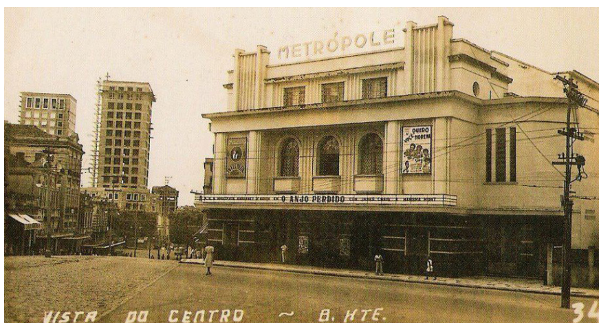
Figura 13: Cine Metr pole, 1942, arquiteto Raffaello Berti
