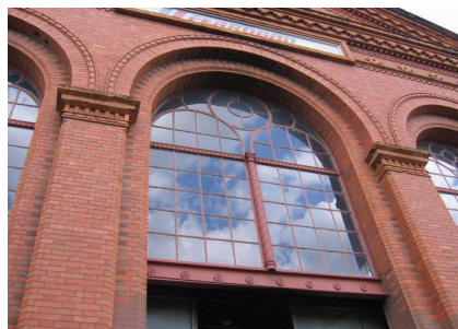
Figura 4. Tipologia das janelas encontradas na fachada principal do edifício da Seção de locomotivas
