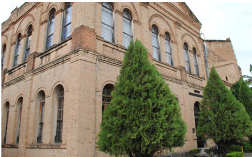
Figura 1. Edifício onde se encontra a biblioteca do Museu Ferroviário de Jundiaí
